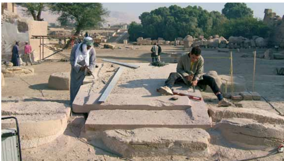
B.- Réfection de l'escalier conduisant à la «fenêtre d'apparition». [Cliché © Christian Leblanc-MAFTO/ASR].
