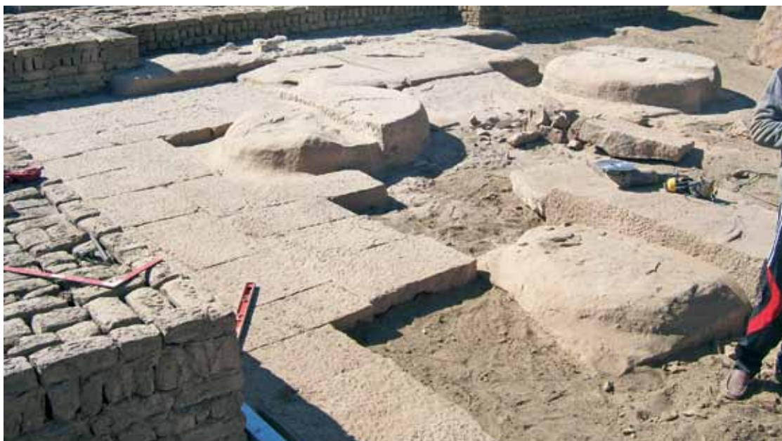
A.- Ramesseum. Travail en cours : réfection du dallage en grès dans la «salle du trône» du palais royal. [Cliché © Christian Leblanc-MAFTO/ASR].
