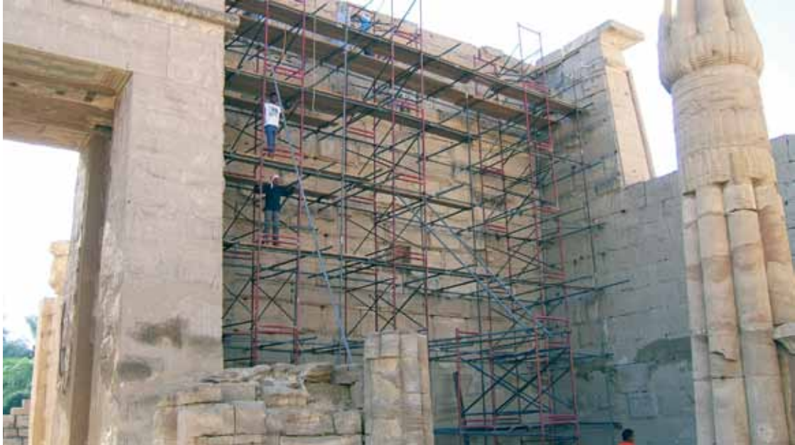
A.- Medinet Habou. Échafaudage dressé contre l'un des montants du pylône de Ptolémée VIII. Relevé photographique des blocs provenant du Ramesseum et remployés en assises dans la construction. [Cliché © Christian Leblanc-MAFTO/ASR].
