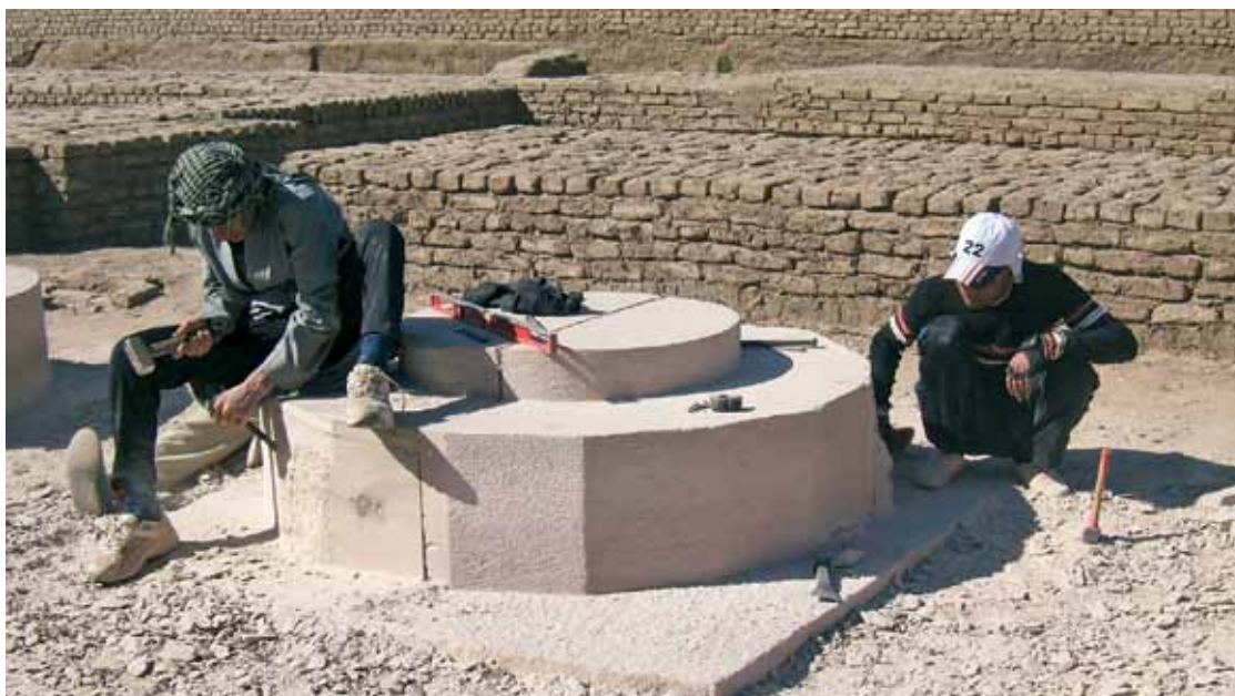
A.- Ramesseum. Dans la «salle de réception» du palais royal, restitution d'une des bases de colonnes disparues de la dernière rangée ouest. [Cliché © Christian Leblanc-MAFTO/ASR].
