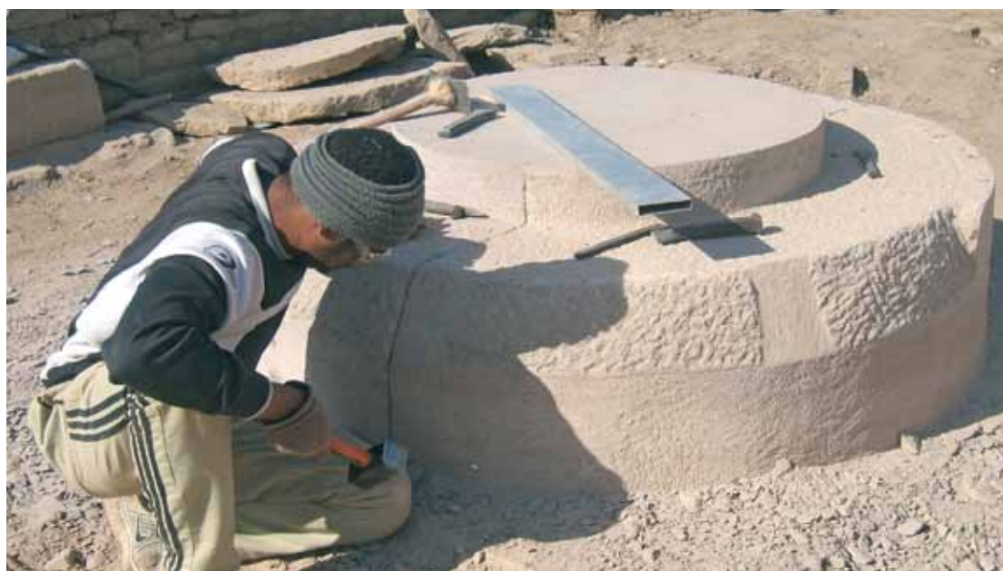
B.- Taille d'une autre base de colonne. [Cliché © Christian Leblanc-MAFTO/ASR].
