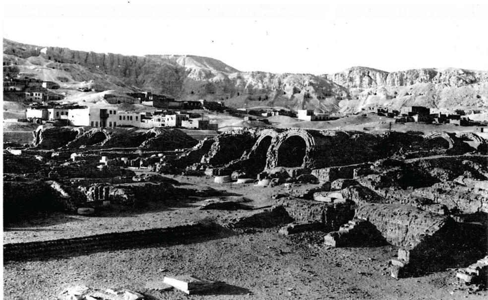
1. - Le secteur nord-ouest des annexes du temple, et les magasins antiques voûtés en brique crue. (Cliché Abdallah Abdel Latif Nasr, archives CEDAE).
