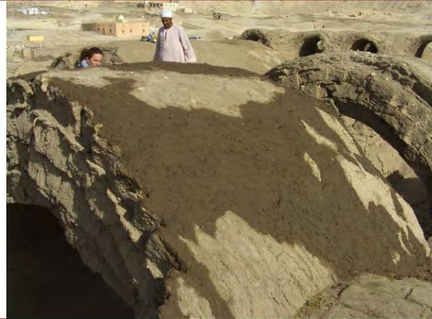
*STA.SA13: protection des voûtes avec de la mouna sans recouvrir le mortier originel (mortier encore frais)*
