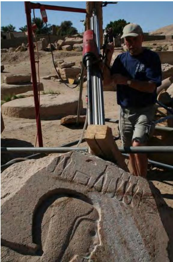
Le premier forage avec un angle incliné de l'ordre de 30° par rapport au plan de cisaillement afin de ne pas endommager les faces polies ou présentant des iconographies. Il recoupe la fissure ouverte à la profondeur de 0.25m et se prolonge jusqu'à 0.58m.
