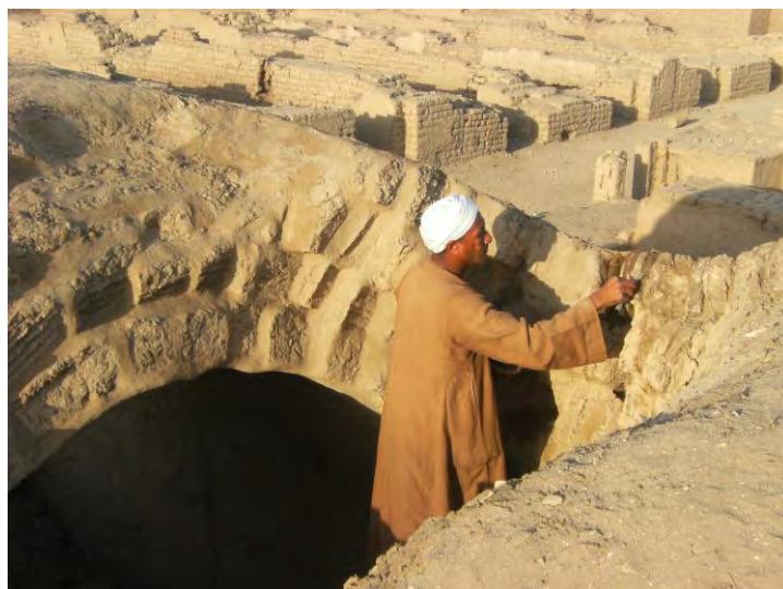
Fig.6 - Consolidación de los adobes de una bóveda, Ramesseum (Créditos: K. Colonna-Prete, 2010)
