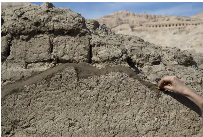
Fig.5 - Aplicación de un bisel, Ramesseum (Créditos: Y. Rantier, 2009)
