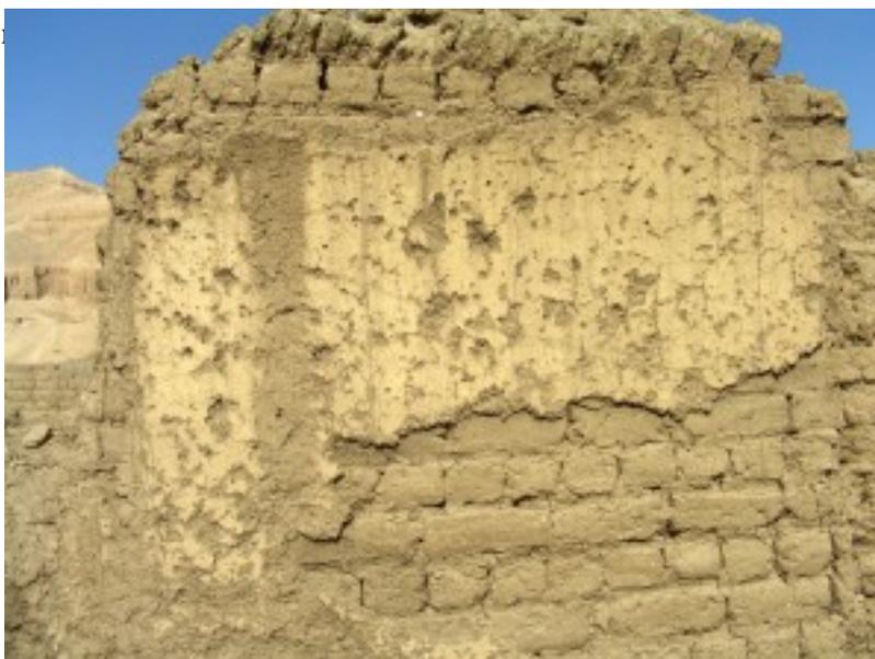
Mur en briques recouvert par un enduit de terre lui-même revêtu d'un enduit de surface clair
